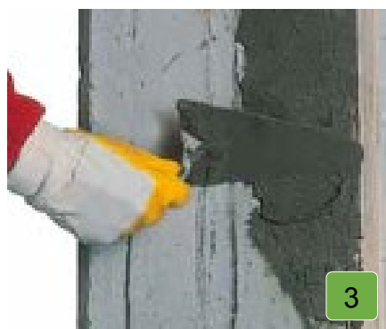
3 הרטב את התשתית במים ומרח את גראוט השיקום ADEGROUT MAXI מבלי להשאיר חללים.
