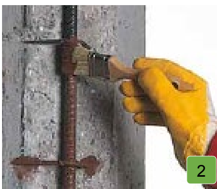
2 באמצעות מברשת, מרח שכבה אחידה של דייס ADEFER נגד קורוזיה, על הברזל ועל הבטון הדורש שיקום.
